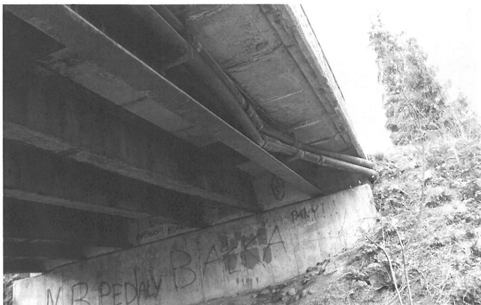
Fot.5 – Spód ustroju zespolonego, przyczółek od strony Nowej Białej
